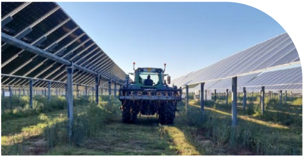
Giugliano Solar Asset (Italy) - NextEnergy 5
